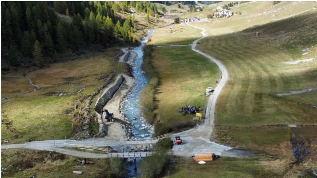
Revitalisierungsmassnahmen an der Fedacla im Fextal
